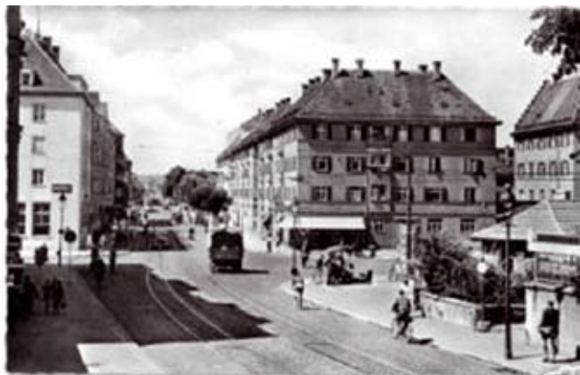
Der westliche Ausgang der Pferseer Unterführung, vor Jahren noch ein Idyll, wird in Zukunft ein hochbelasteter Straßenbahnknoten
