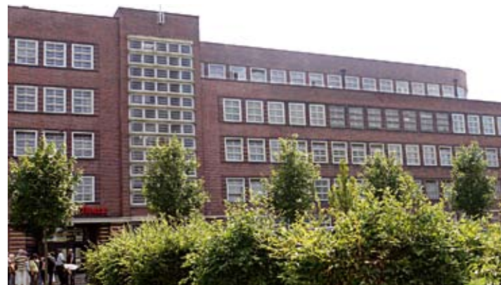
Die ehemalige Konsumzentrale in Plagwitz
