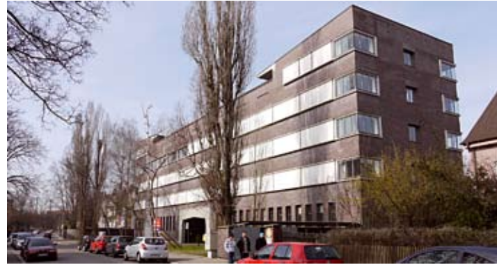
Fernsprechbezirksgebäude in der Stadtjägerstraße (1928)
